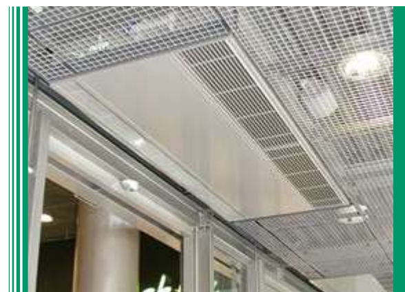
VENTILACIÓN ROOF TOP
