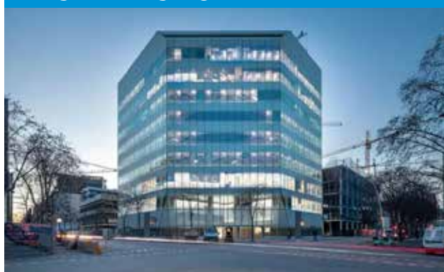
Hexagon Building 22@ Oficinas
