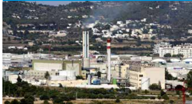
Central térmica GESA
