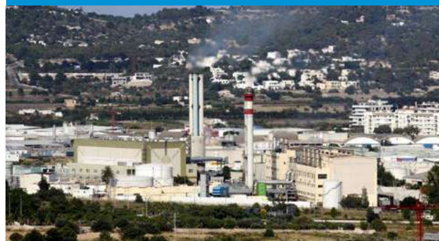
Central térmica GESA
