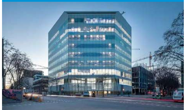
Hexagon Building 22@ Oficinas
